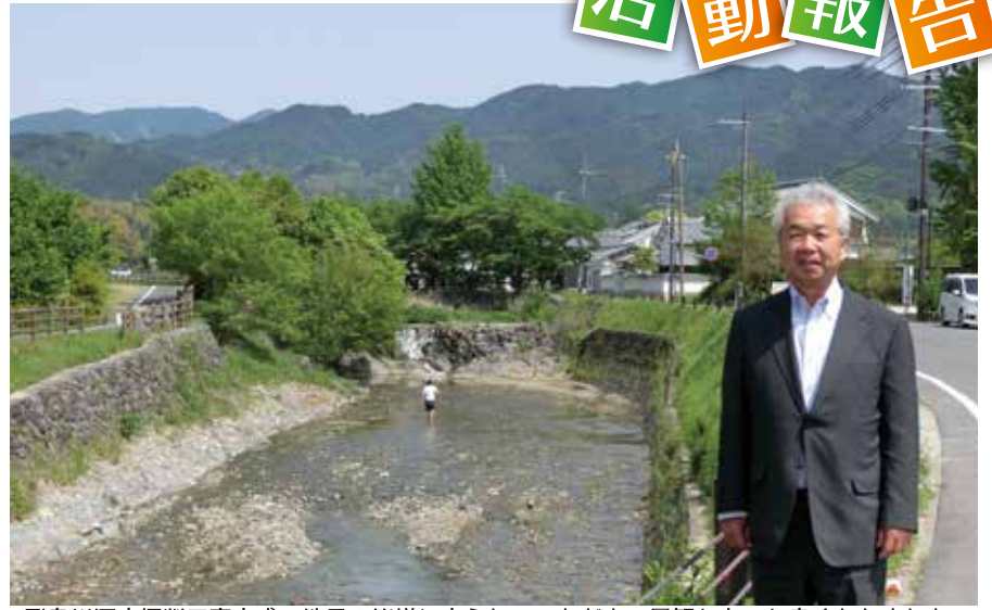
▶ 飛鳥川河床掘削工事完成。地元の皆様にご安心いただき、景観もとても良くなりました。
