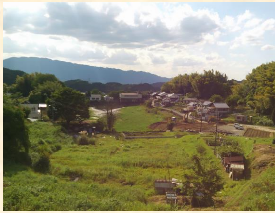
▶高取町赤坂池埋立工事
